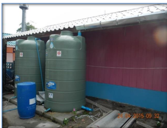
ถังน้ำรองน้ำฝนที่ติดตั้งไว้ที่โรงเรียนบ้านเกาะบุโหลนดอน
