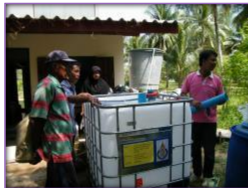
ถังหมักผลิตก๊าซชีวภาพติดตั้งไว้ที่โรงเรียนทั้งสองเกาะ
