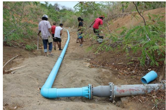
เดินท่อส่งน้ำจากอ่างเก็บมายังถังเก็บน้ำ
