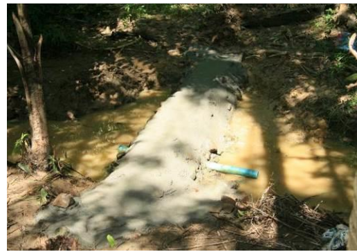
กิจกรรมสร้างขยายฝายชะลอน้ำครั้งที่ ๒ เพื่อให้กักเก็บน้ำได้มากขึ้น
