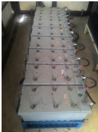
โซลาร์เซลล์ และระบบไฟฟ้า ที่ได้ติดตั้งให้กับโรงเรียนบ้านเกาะบูโหลนตอน จังหวัดสตูล
