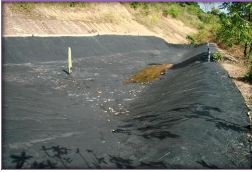
ปูแผ่นยางพาราธรรมชาติที่อ่างเก็บน้ำเกาะบุโหลนดอน
