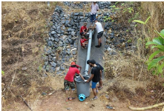
เดินท่อส่งน้ำจากอ่างเก็บมายังถังเก็บน้ำ
