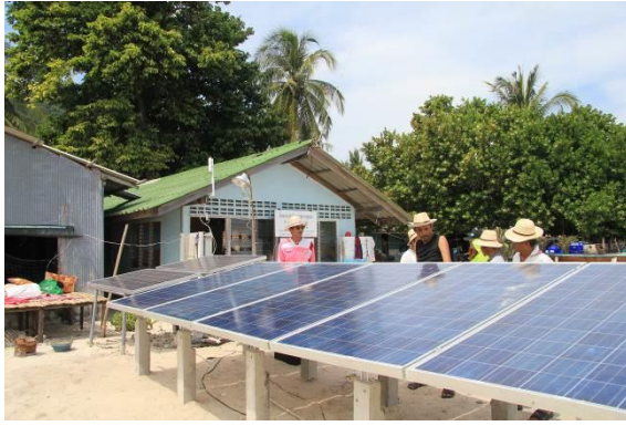
ระบบโซลาร์เซลล์ขนาด ๑.๕ kW ติดตั้งด้านหน้าสุรศาลา
