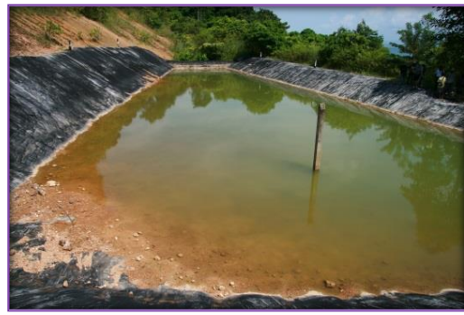
ปูแผ่นยางพาราธรรมชาติที่อ่างเก็บน้ำเกาะบุโหลนดอน
