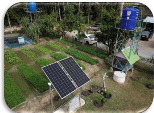
ภาพที่ 2 แสดงการติดตั้งระบบสูบน้ำพลังงานแสงอาทิตย์เพื่อการปลูกผักสวนครัวโรงเรียนอุดมศาสตร์วิทยา จ.ยะลา
