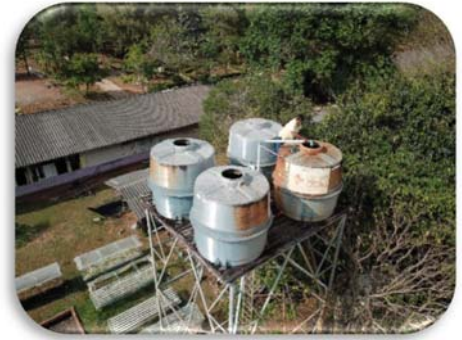
ถังน้ำขนาด 16 ลูกบาศก์เมตร สูงจากพื้นดิน 13 เมตร
